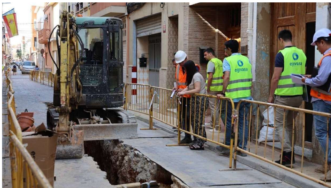
Obras en la red de alcantarillado de Catarroja tras la dana -
